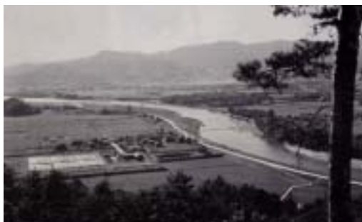
昭和 27 年戸坂浄水場
