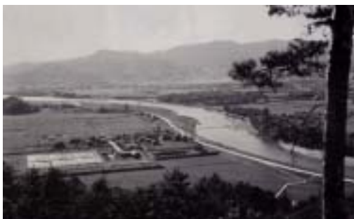
昭和 27 年戸坂浄水場
