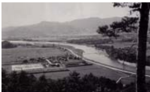
昭和 27 年戸坂浄水場
