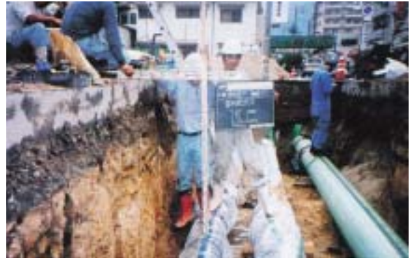
水道管布設状況 (広島ガスのガス管と共同施工)
