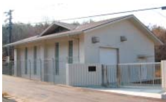
狐城ポンプ所（呉市押込6丁目） (送水能力増強施設)
