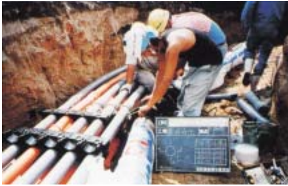
水道管布設状況 (NTT通信ケーブルと共同施工)
