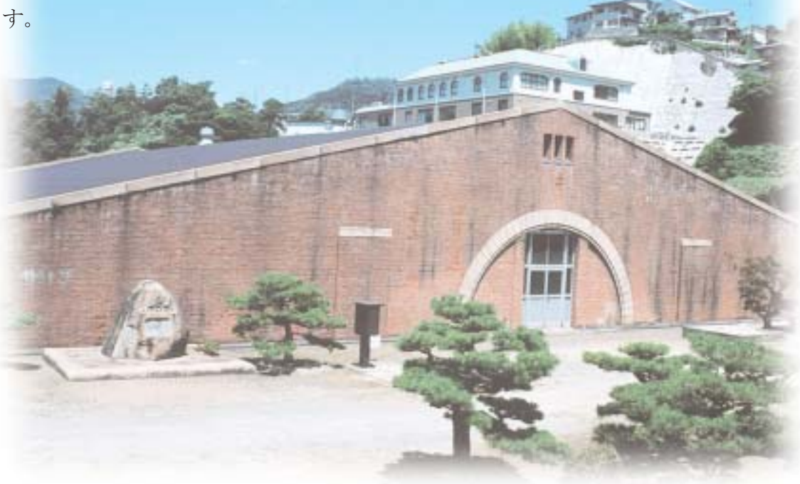
宮原浄水場低区配水池
